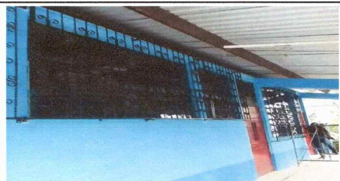
Foto 5: Sustrucción de vidrios
