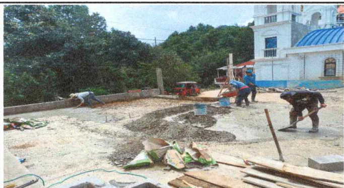
Foto 3: Sustrucción de piso
