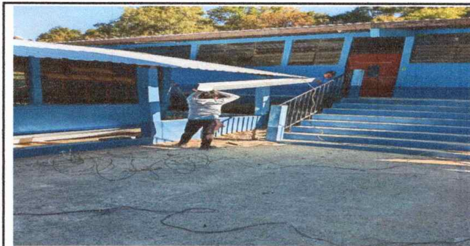
Foto 6: Sustrucción de canales
