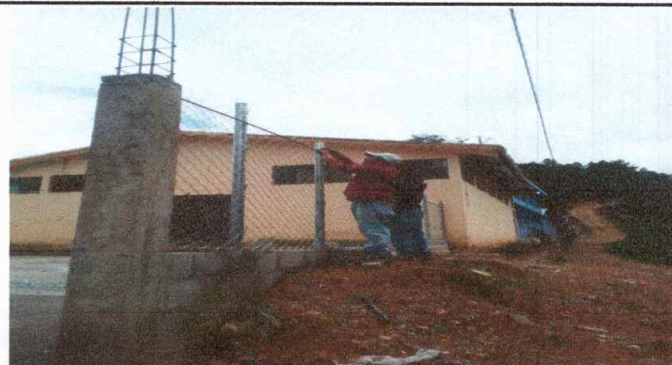
Foto 2: Sustrucción de malla y tubos de metal
