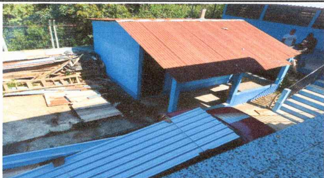
Foto 1: Sustrucción de laminas por troqueladas
