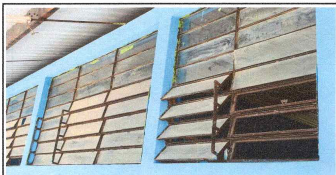
Foto 5: Sustrucción de vidrios
