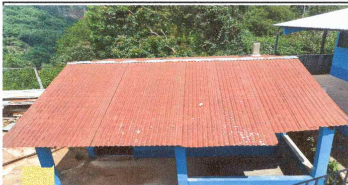
Foto 1: Sustrucción de laminas por troqueladas
