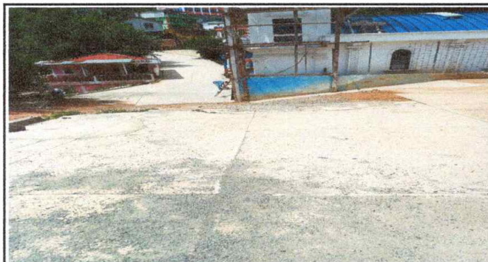
Foto 3: Sustrucción de piso
