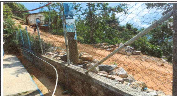
Foto 2: Sustrucción de malla y tubos de metal
