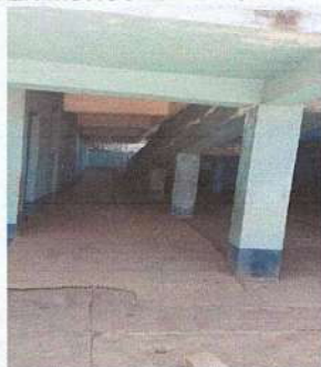
Foto 11: Pintura corredor de las dos aulas primer nivel.
