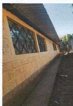
Foto 8.3: Sustitución de vidrios de ventana atrás de la escuela No. 2
