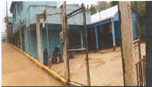
Foto 3: Sustitución e instalación de tubos perimetrales para mallas.
