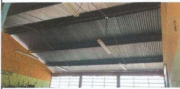
Foto 2: Instalación de complemento de soporte de metal por metal.
