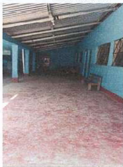
Foto 8.2: Sustitución de vidrios de ventanas corredor de la escuela No. 2
