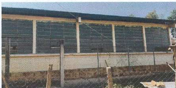
Foto 3.2: Sustitución de malla perimetral por malla galvanizada atrás de la escuela No. 1
