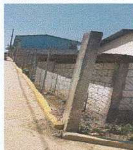
Foto 3.1: Sustitución de malla perimetral por malla galvanizada frente la escuela.
