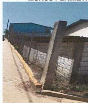
Foto 3.1: Sustitución de malla perimetral por malla galvanizada frente la escuela.
