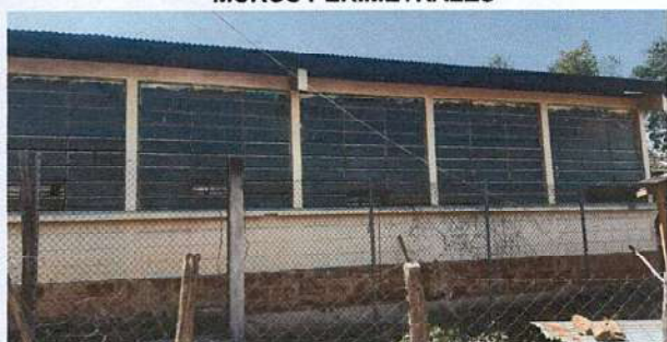
Foto 3.2: Sustitución de malla perimetral por malla galvanizada atrás de la escuela No. 1
