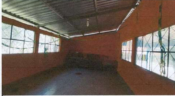
Foto 10: Pintura dentro y afuera de las dos aulas No. 8 y 9
