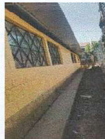
Foto 3.3: Sustitución de malla perimetral por malla galvanizada atrás de la escuela No. 2
