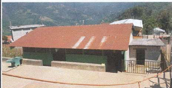
Foto1: Sustitución de lámina, por lámina troquelada aluzinc calibre 24 de la escuela No. 1 y de la cocina que se encuentra a la par.
