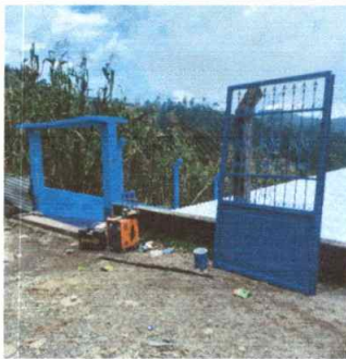
Foto 3: Colocación de Portón
