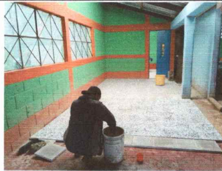
Foto 2: Colocación de Piso
