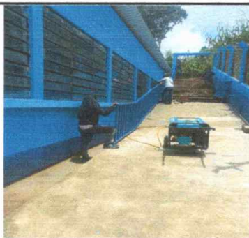
Foto 5: Instalación de Barandas
