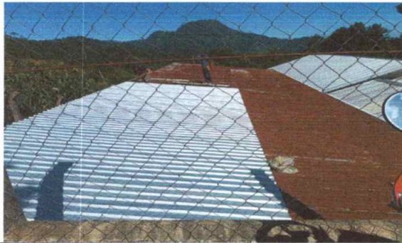
Foto1: Colocación de Láminas
