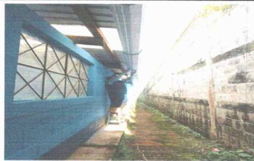
Foto 4: Colocación de Canales
