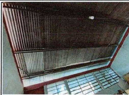
Foto 2: Estructura de techo
