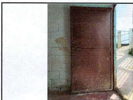
Foto 4.1: Sustitución de puertas
