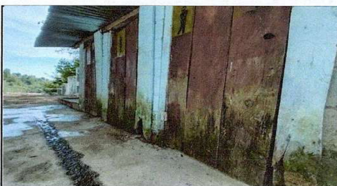
Foto 4: Sustitución de puertas de metal
