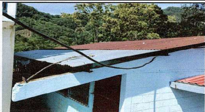
Foto1: Cubierta de lámina
