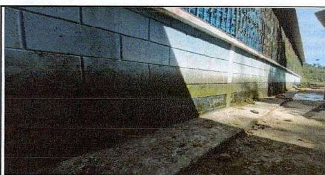
Foto 5: Canales y bajadas de agua pluvial
