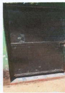
Foto 2.1: Sustitución de puertas de baño en mal estado
