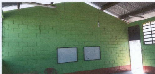
Foto 4.7: Pintura dentro del aula No. 1
