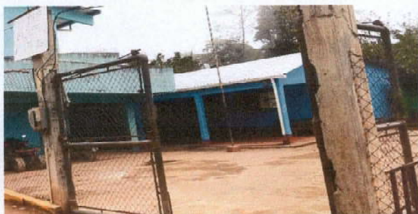
Foto 3: Sustitución de portón de la escuela.
