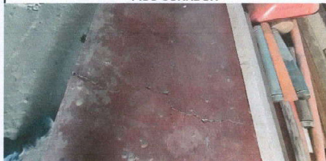
Foto 1.3: Sustitución de piso granito corredor de la escuela No 3
