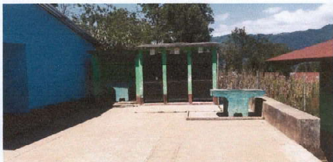
Foto 2: Sustitución de las 3 puertas de baños en mal estado
