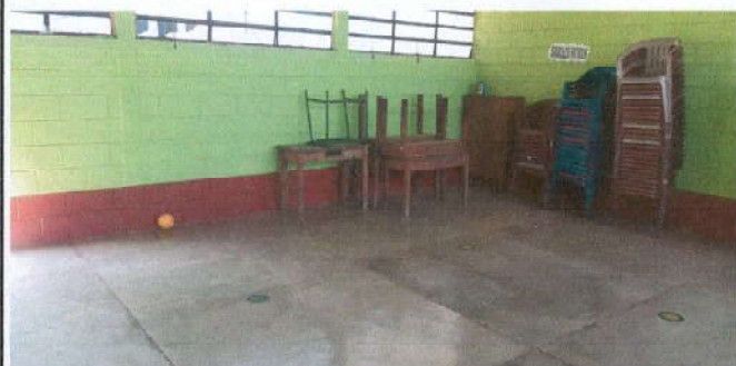
Foto1: Sustitución de piso granito dentro del aula No. 1
