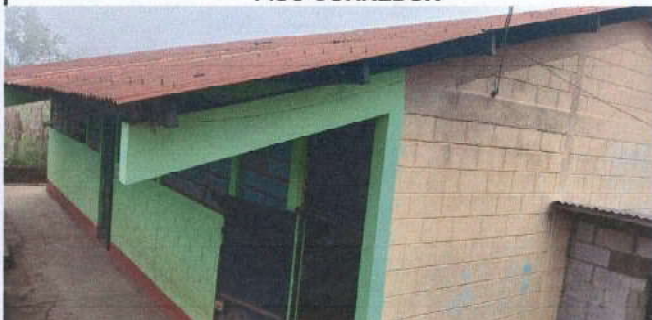
Foto 1.2: Sustitución de piso granito corredor de la escuela No. 1
