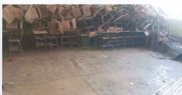
Foto 1.1: Sustitución de piso granito corredor de la escuela No 2
