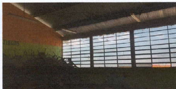
Foto 4.6: Pintura dentro del aula No. 1
