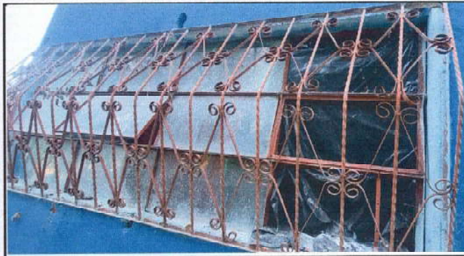
Foto 2. Ventanas de aulas y Salón.
