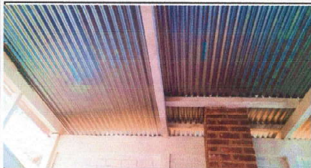
SUSTITUCIÓN DE LAMINA
