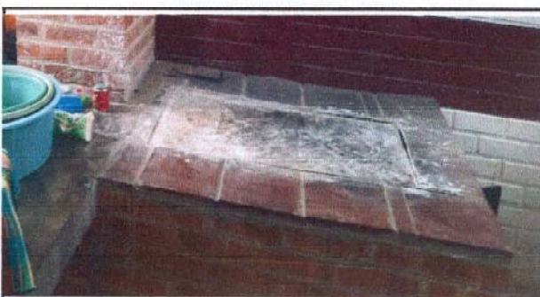
MANTENIMIENTO DE PLANCHA DE CONCRETO
