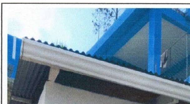
SUSTITUCIÓN DE CANAL
