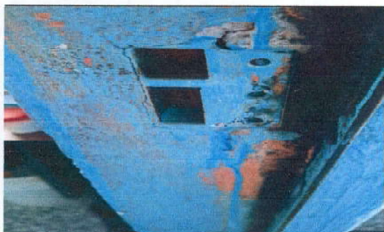
SUSTITUCIÓN DE CHAPA
