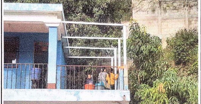
Foto. Estructura de techo
