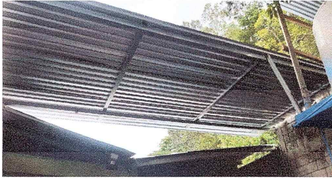
Foto. 1 Cubierta de lamina
