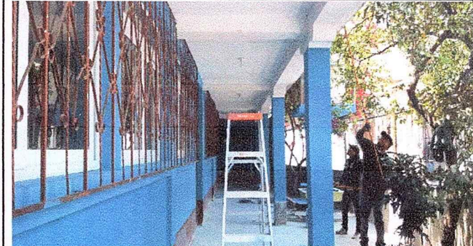
Foto. 4 Pintura en Muros exteriores e interiores
