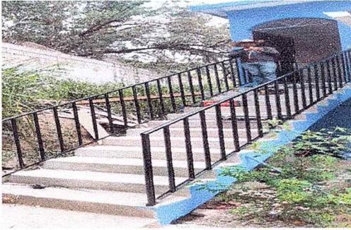
Foto 7 Mantenimiento a Barandas
