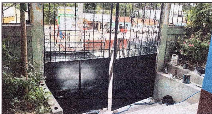
Foto 5. Mantenimiento a portones
