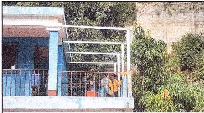
Foto 2 Estructura de Techo.
