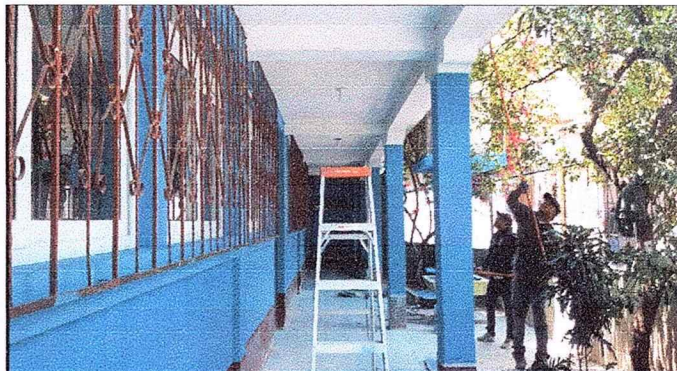
Foto 4 Pintura en muros exteriores e interiores
