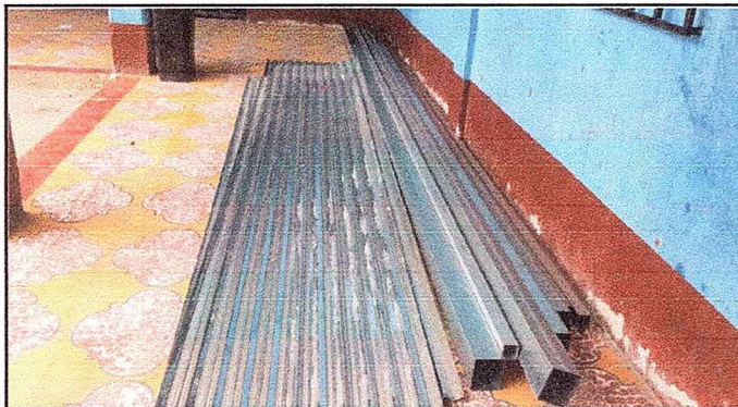
Foto 1 Cubierta de lámina
