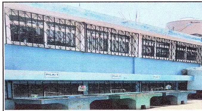
Foto 4: Pintura en muros exteriores e Interiores.
