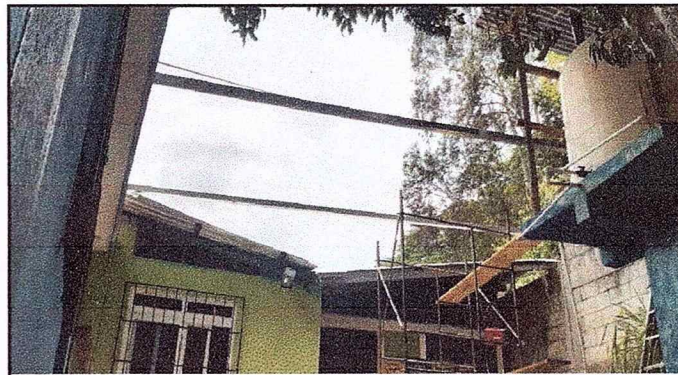
Foto 2: Estructura de techo.
