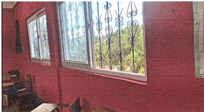
Foto 4: pintura en muros interiores 960 mts cuadrados
