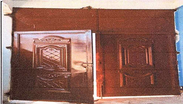
Foto 2: sustitución de portón de 2.16 mts ancho por 2.77 mts alto
