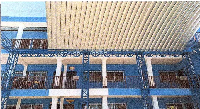
Foto 5: sustitución de dos barandas una de 29 mts y la otra de 21 metros ambas lineales con una altura de 100 cm
