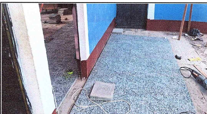
Foto 3: sustitución de piso tipo cerámica por piso tipo granito de 31 X 31 fondo verde
