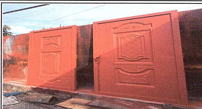
Foto 2: sustitución de portón de 2.16 mts ancho por 2.77 mts alto
