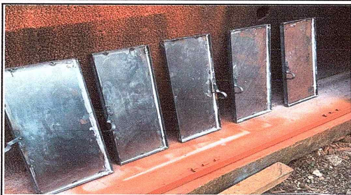
Foto 1: sustitución de 12 ventanillas marco de metal y vidrio por 12 ventanillas de metal
