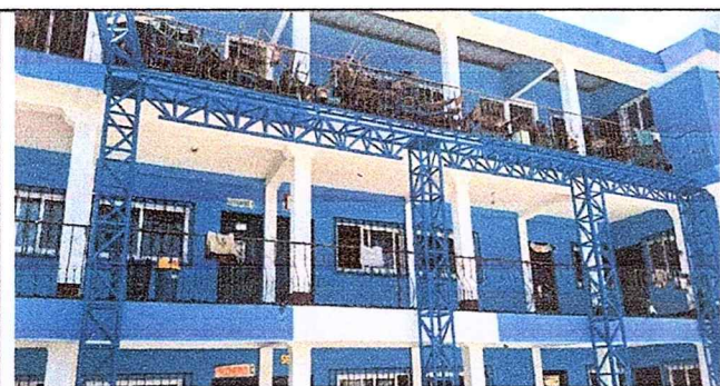
Foto 5: barandas del segundo y tercer nivel con más de 28 años de antigüedad
