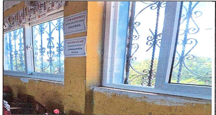
Foto 4: pintura en muros interiores 960 mts cuadrados
