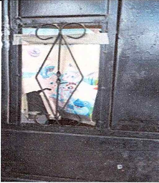
Foto 1 : sustitución de 12 ventanillas marco de metaly vidrio por 12 ventanillas de metal
