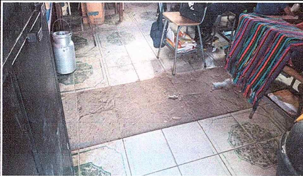
Foto 3: sustitución de piso tipo cerámica por piso tipo granito de 31 X 31 fondo verde
