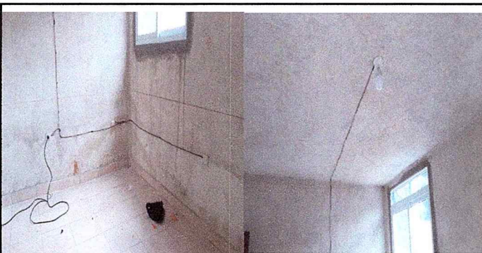
Foto. 5 Reparación de sistema eléctrico.
