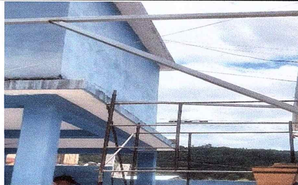
Foto. 2 Estructura de techo
