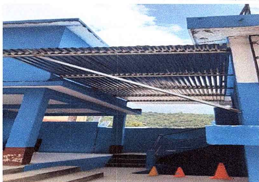
Foto. 1 Cubierta de lámina
