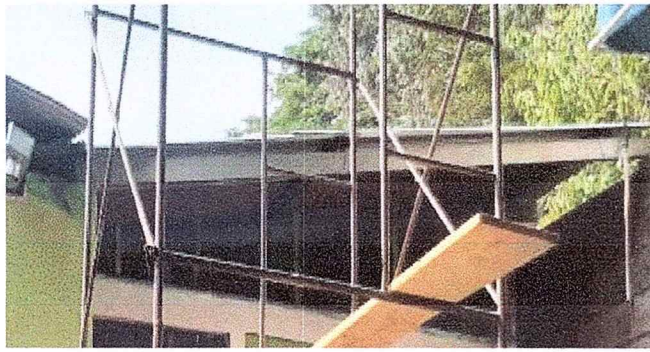
Foto. 1 Cubierta de lámina
