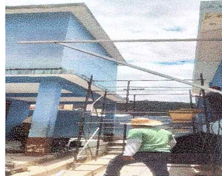
Foto. 2 Estructura de techo.
