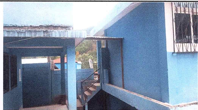
Foto. 2 Estructura de Techo.
