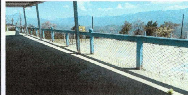
Foto 6: Reparación de muro perimetral con malla galvanizada
