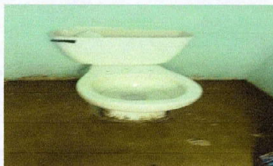
Foto 8: Sustitución de inodoro
