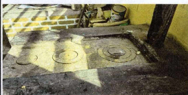
Foto 5: Sustrucción de estufa rural (completa) incluye chimenea y plancha de metal
