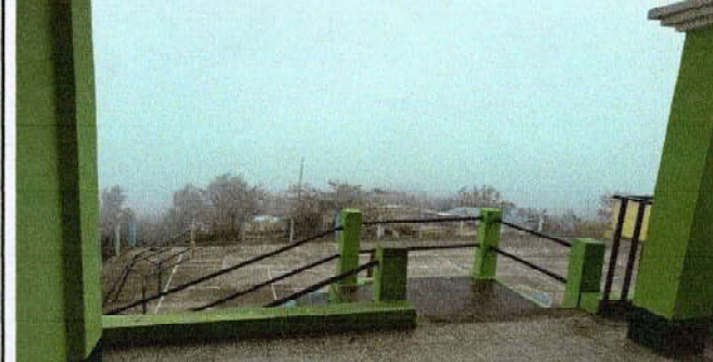
Foto 4: Fabricación e instalación de baranda
