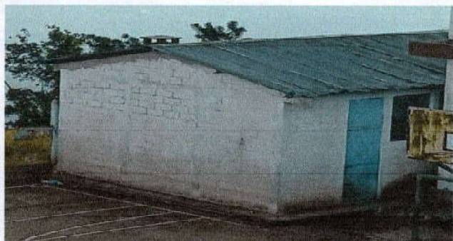
Foto 7: Repello en la pared dentro y fuera de la cocina con monocapa blanco
