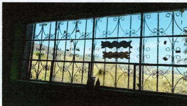
Foto1: Sustrucción de estructura de metal de ventana por PVC
