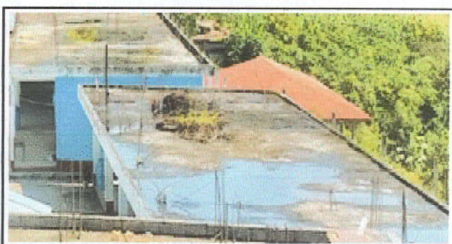
Foto 6: Impermeablización de losa
