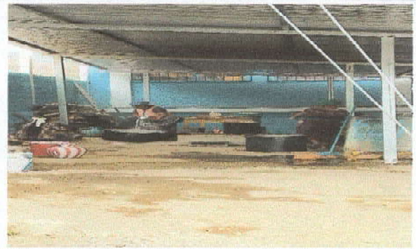
Foto 2: sustitucion de piso de torta de concreto en la cocina
