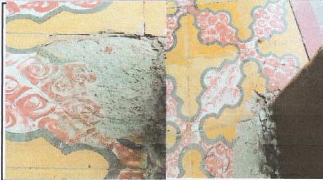
Foto1: Sustitución de piso de granito en tres aulas, dirección y corredor
