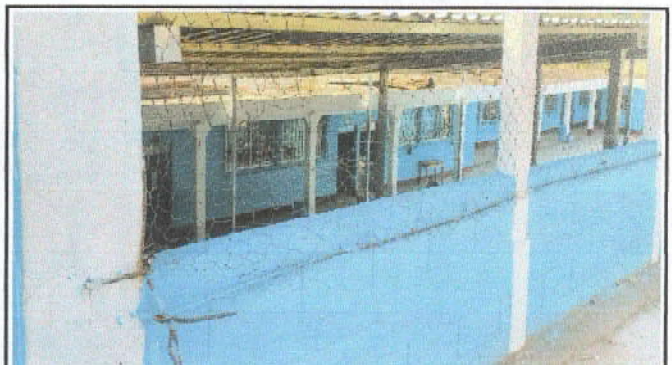
Foto 4: Reparación de malla galvanizada AG para circulacion de la escuela.
