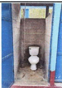
Foto 11: Paredes de servicios sanitarios necesitan ser repellados.
