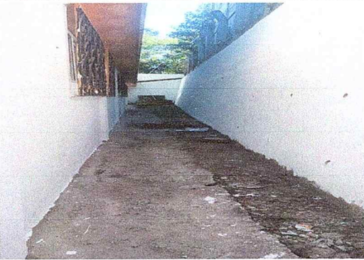
Foto 9: Pintura en muros exteriores
