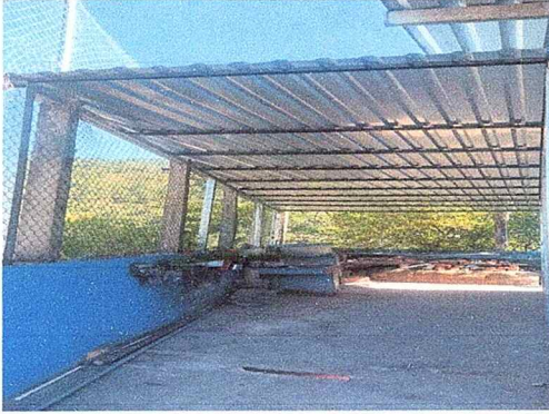
Foto7: Cubierta de lamina
