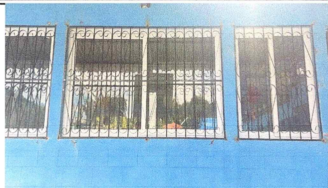
Foto1: Sustitución de balcones
