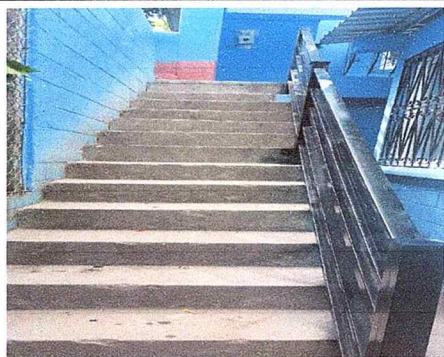
Foto 5: Sustitución de baranda
