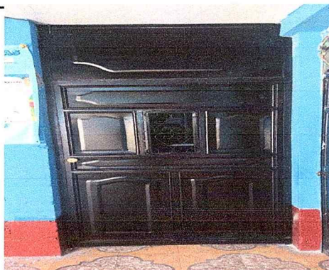
Foto 3: Sustitución de puerta
