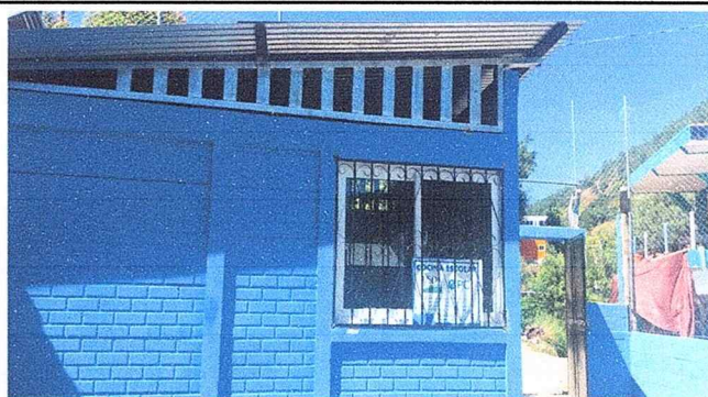
Foto 4: Mejoramiento de rejilla de metal
