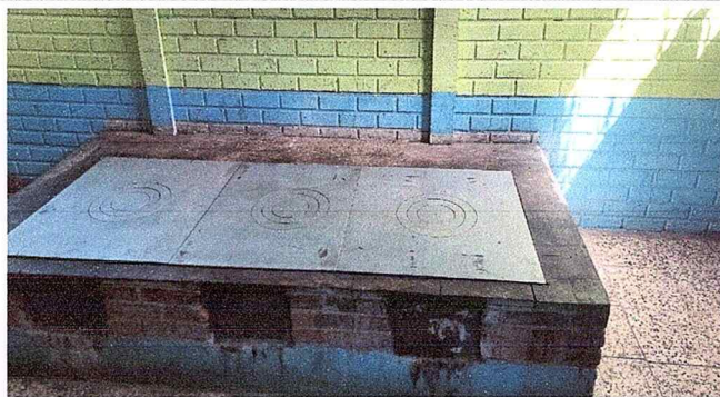
Foto 6: Sustitución de plancha de metal
