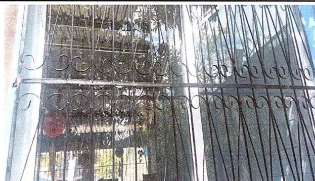
Foto 2: Sustitución de ventanas
