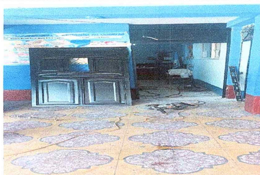
Foto 3: Sustitución de puerta
