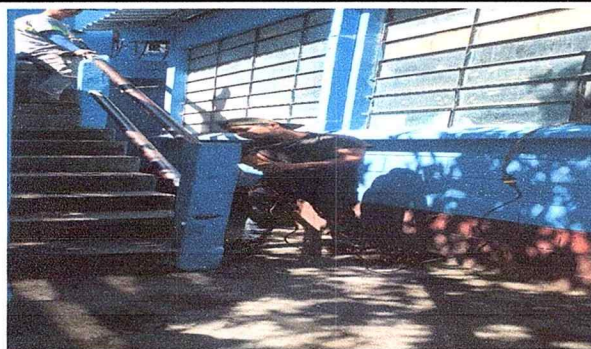
Foto 5: Sustitución de baranda
