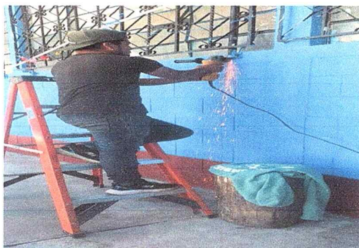
Foto No. 1 Sustitución de balcones
