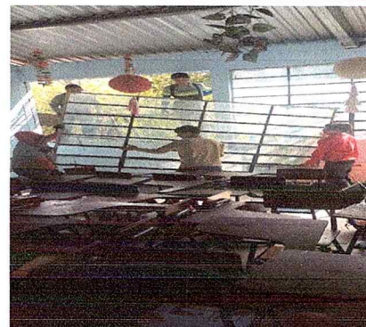
Foto No. 2 Sustitución de ventanas
