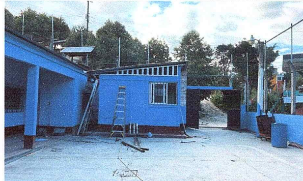
Foto 4: Mejoramiento de regillas de metal
