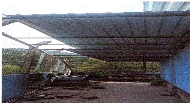
Foto 7 Cubierta de lamina
