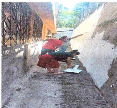
Foto 9 Pintura de muros exteriores
