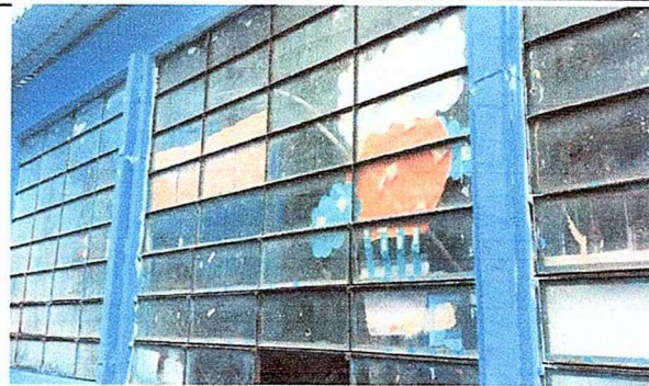
Foto No. 2 Sustrucción de ventanas
