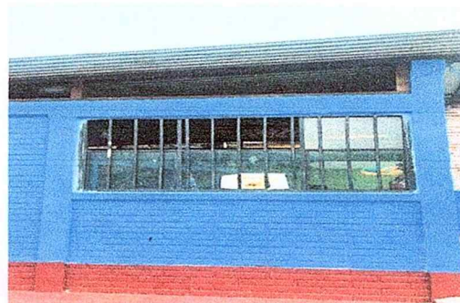
Foto No. 4 Mejoramiento de regilla de metal
