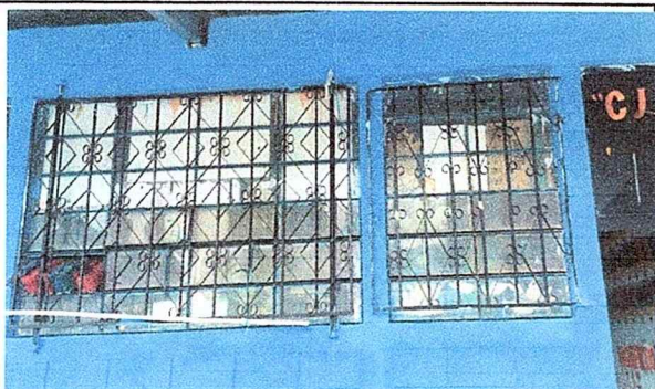
Foto No. 1 Sustrucción de balcones
