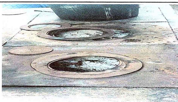
Foto No. 6 Sustrucción de plancha de metal
