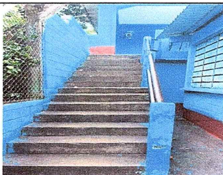
Foto No. 5 Sustrucción de baranda
