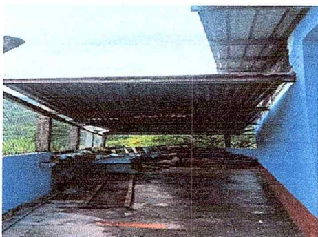
Foto No. 7 Cubierta de lamina
