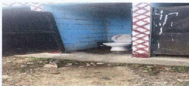
Sustitución de sanitarios y azulejo
