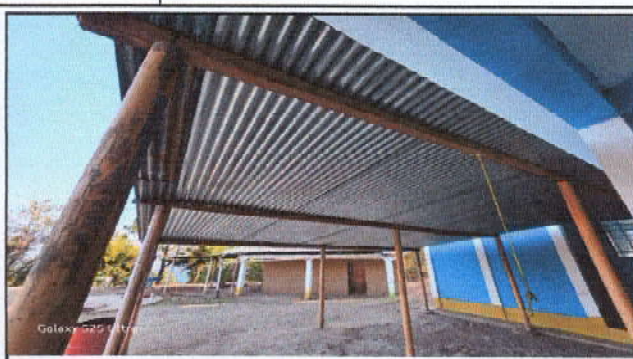
SUSTITUCIÓN DE ESTRUCTURA DE SOPORTE DE TECHO
