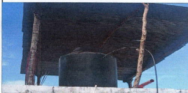
Sustitución de depósito de agua
