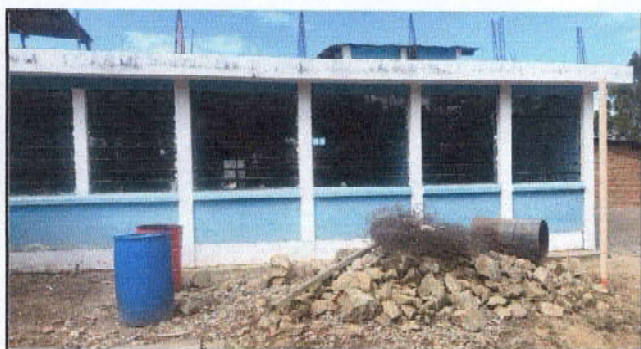
PINTURA EN MUROS EXTERIORES E INTERIORES
