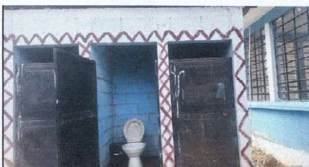
PINTAR PUERTAS DE SANITARIOS
