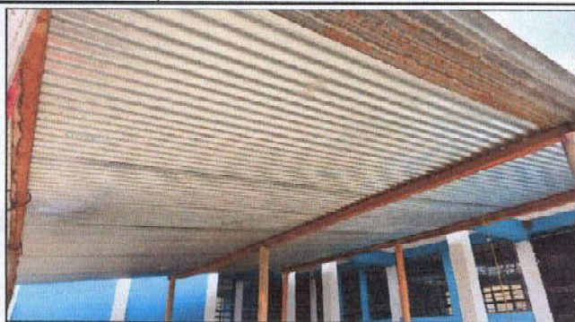
SUSTITUCIÓN DE LAMINA
