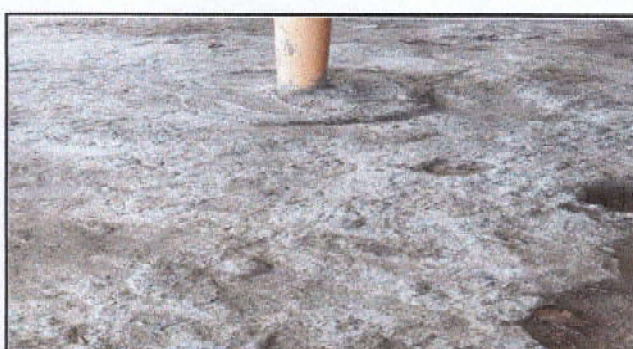
REPARACIÓN DE TORTA DE CONCRETO
