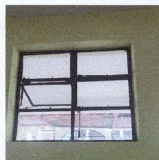
FOTO 8: SUSTITUCIÓN DE VENTANAS EN AULAS
