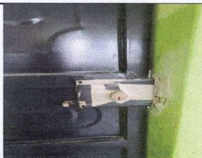
FOTO 3: SUSTITUCIÓN DE CHAPAS
