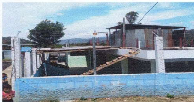
FOTO 2: SUSTITUCIÓN DE LÁMINA TROQUELADA
