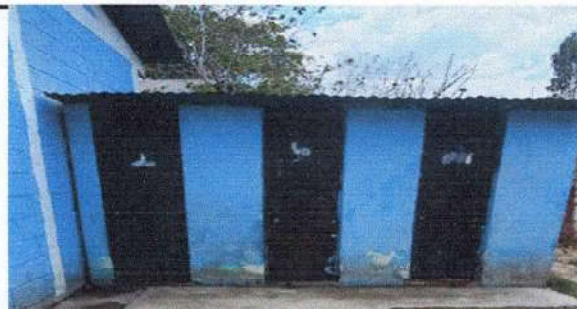
FOTO 6: SUSTITUCIÓN DE PUERTAS DE SERVICIOS SANITARIOS
