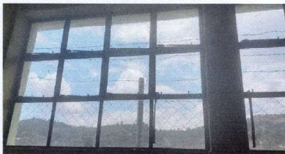
FOTO 7: SUSTITUCIÓN DE VENTANAS DE AULAS
