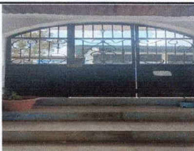
FOTO 5: MANTENIMIENTO A PORTON
