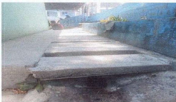
FOTO 1: MEJORAMIENTO DE REJILLAS EN CUNETA
