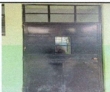
FOTO 4: MANTENIMIENTO DE PUERTAS
