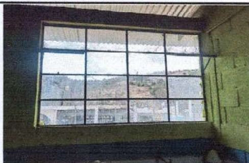
FOTO 9: SUSTITUCIÓN DE VENTANAS EN AULAS
