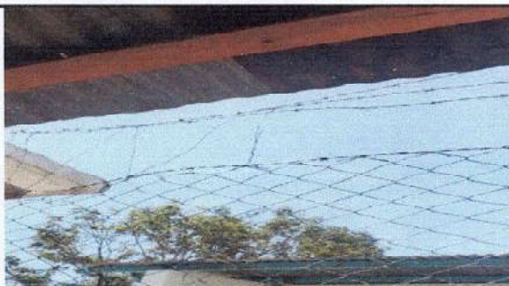
SUSTITUCIÓN DE ALAMBRE DE PUAS
