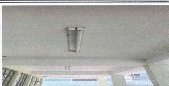
SUSTITUCIÓN DE LÁMPARAS
