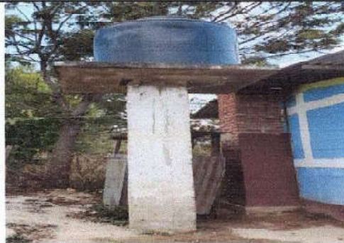
SUSTITUCIÓN DE DEPÓSITO
