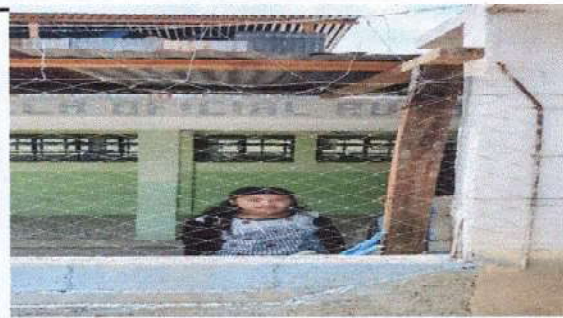
SUSTITUCIÓN DE MURO PERIMETRAL
