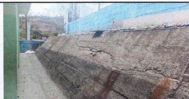
SUSTITUCIÓN DE REPELLOS EN MUROS
