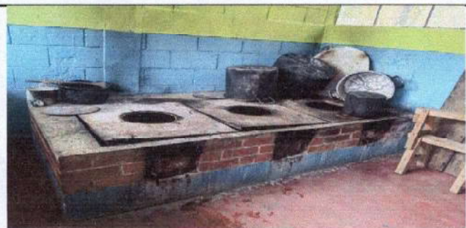
REPARACIÓN DE COCINA COMPLETA
