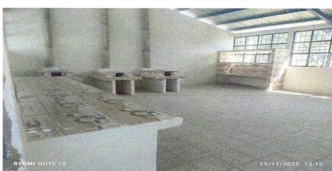
Foto 4: Reparación y construcción de cocina, finalizado.
