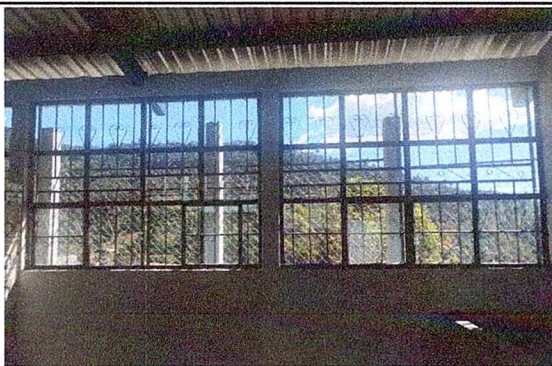
Foto 4: Ventanas instaladas, finalizadas.
