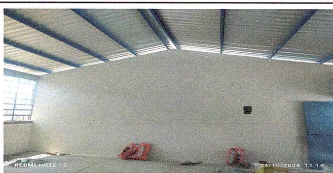
Foto 2 : Estructura de techo de metal, sustituido y finalizado.
