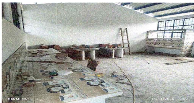
Foto 3: Sustitución de torta de cemento por piso de granito, finalizado.
