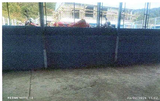
Foto 6: Reparación y muro perimetral, finalizado.
