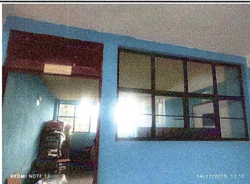
Foto 4: Ventanas en reparación.
