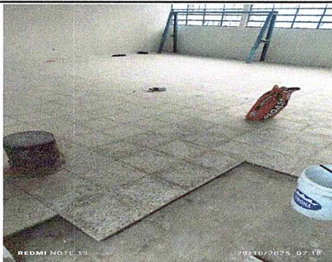
Foto 3: Sustitución de piso por granito
