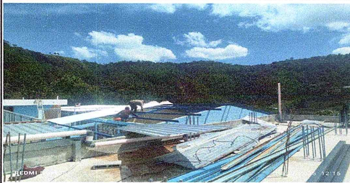
Foto1: Sustitución de lámina de metal troquelada.
