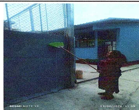
Foto 6: Pintado y remozamiento de muro perimetral.
