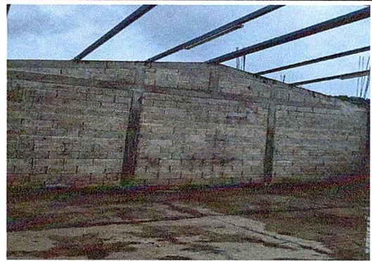
Foto 2 : Cambio de estructura de techo de metal.
