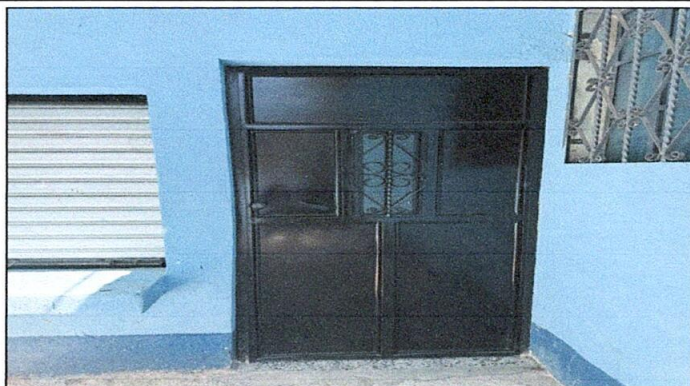
MANTENIMIENTO DE PUERTA
