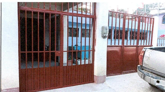
SUSTITUCIÓN DE PORTON
