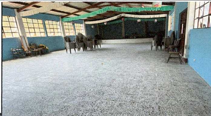
SUSTITUCIÓN DE PISO
