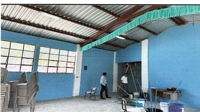
PINTURA EN MUROS EXTERIORES
