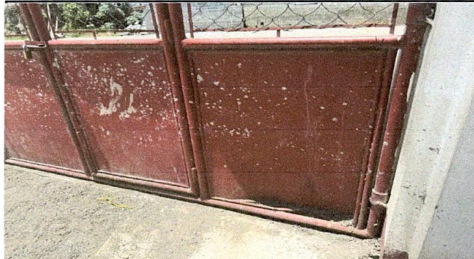
MANTENIMIENTO A PORTON
