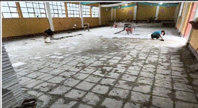
SUSTITUCIÓN DE PISO
