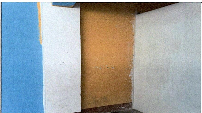
PINTURA EN MUROS EXTERIORES E INTERIORES
