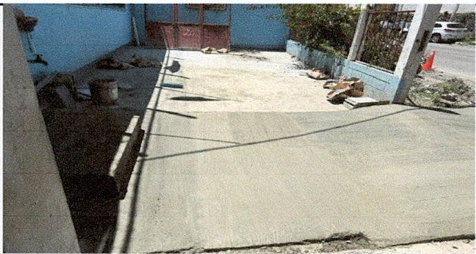
REPARACIÓN DE LOSA DE CONCRETO
