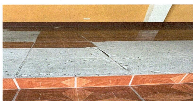
Foto 2: Sustrucción de piso por piso granito
