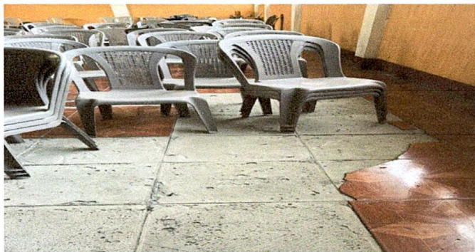
Foto 1: Sustrucción de piso por piso granito
