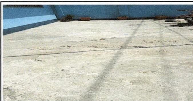
Foto 6: Reparación de losa de patio
