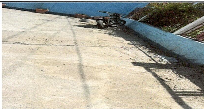
Foto 5: Reparación de losa de patio
