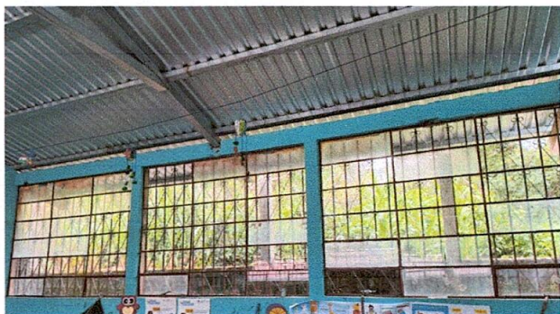
Foto7: Sustitución de vidrios
