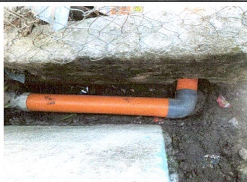
Foto 14: Sustitución de tubería PVC línea principal aguas negras
