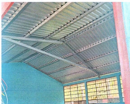
Foto 21: Sustitución de lamina
