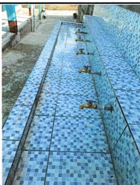
Foto 15: Sustitución de llaves de chorros
