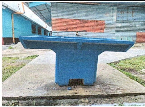
Foto 20: Sustitución de pila de cemento de dos lavadero
