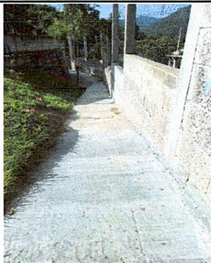
Foto 13: Reparación de cuneta concreto
