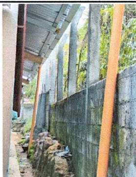
Foto 11: Sustitución de canal PVC + Pescante
