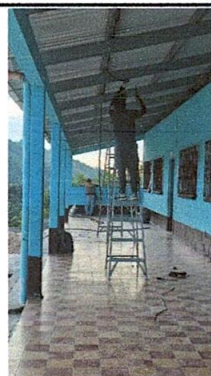
Foto 16: Reparación del sistema eléctrico
