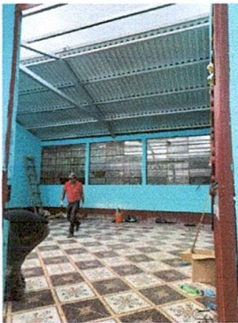
Foto 20: Sustitución de lamina
