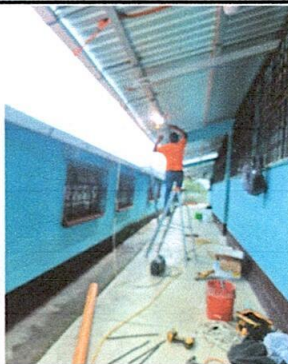
Foto 11: Sustitución de canal PVC + Pescante
