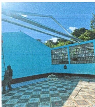
Foto 1: Sustitución de estructura de soporte por metal
