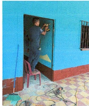
Foto 2: Sustitución de puerta
