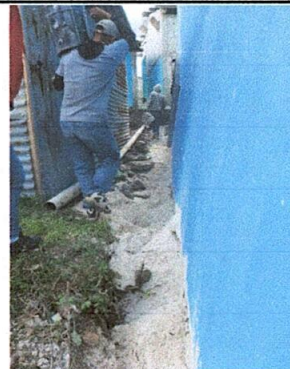
Foto 14: Sustitución de tubería PVC línea principal aguas negras
