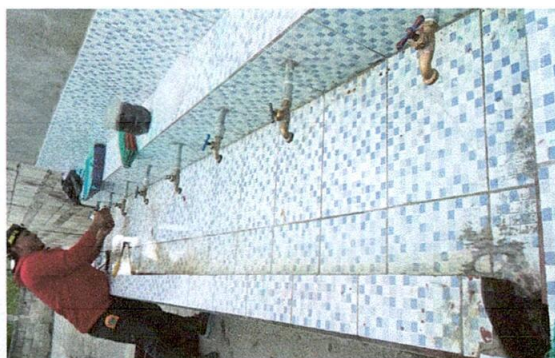
Foto 15: Sustitución de llaves de chorros
