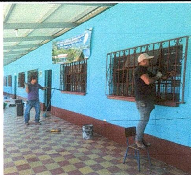
Foto 6: Sustitución de estructura de metal de ventana
