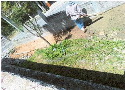
Foto13: Reparación de cuneta concreto
