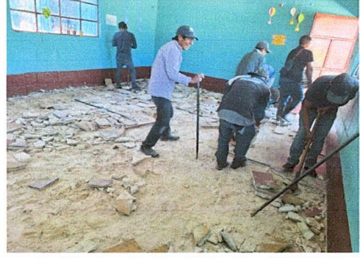
Foto 8: Sustitución de piso de cemento liquido a granito
