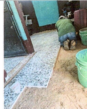
Foto 10: Sustitución de piso liso a piso granito
