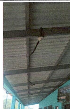
Foto 16: Reparación del sistema eléctrico
