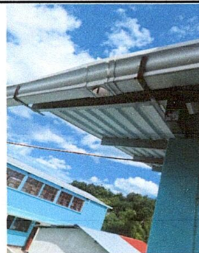
Foto 12: Sustrucción de bajada de agua pluvial de metal por tubo PVC 3
