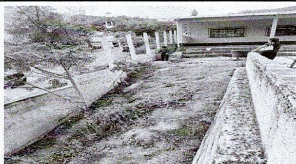
Foto 6: mejoramiento con cuneta de concreto
