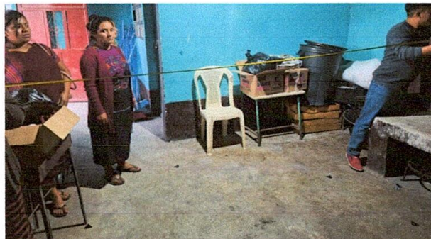
Foto 10: Sustrucción de piso liso a piso granito
