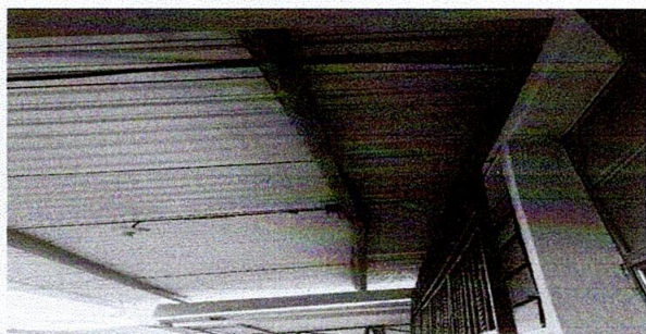
Foto1: Sustrución de estructura de soporte de metal, por metal
