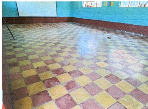
Foto 8: Sustrucción de piso de cemento liquido a granito
