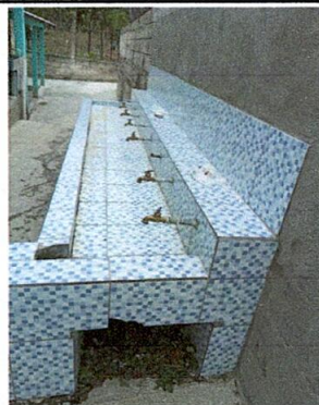
Foto 15: Sustitución de llaves de chorros
