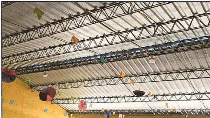
SUSTITUCIÓN DE SOPORTE
