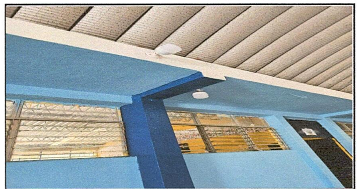
SUSTITUCIÓN DE FOCOS AHORRADORES
