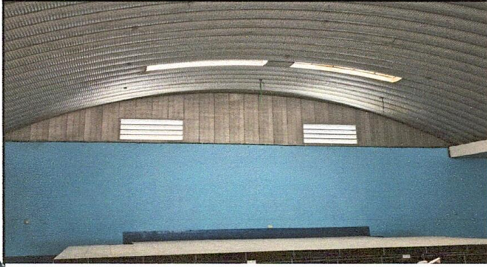
SUSTITUCIÓN DE LAMINA
