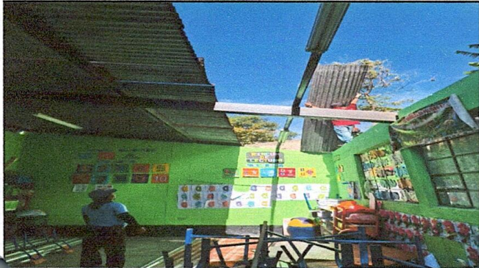
SUSTITUCIÓN DE LAMINA
