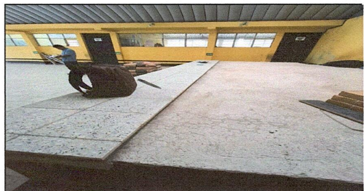
SUSTITUCIÓN DE PISO
