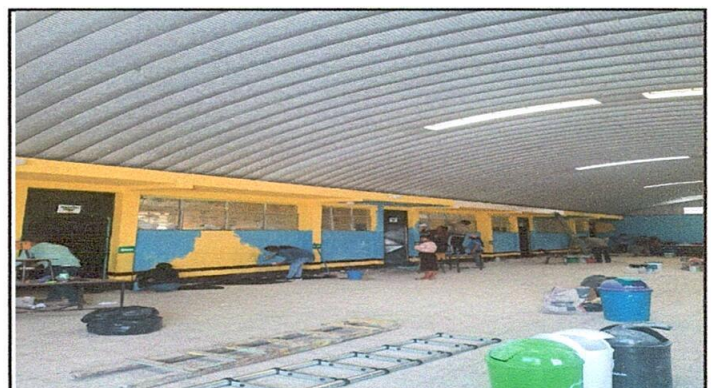
PINTURA EN MUROS EXTERIORES E INTERIORES
