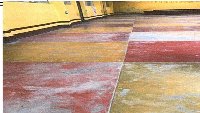
FOTO 2: SUSTITUCIÓN DE PISO POR PISO GRANITO
