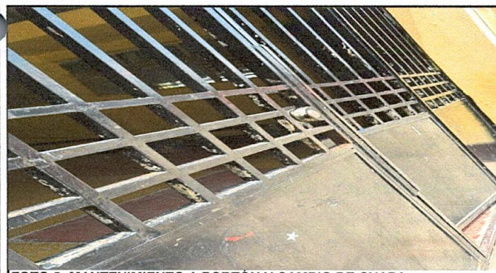
FOTO 5: MANTENIMIENTO A PORTÓN Y CAMBIO DE CHAPA
