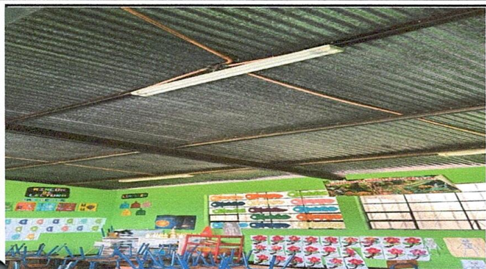
FOTO 1: SUSTITUCIÓN DE LÁMINA POR LÁMINA TROQUELADA
