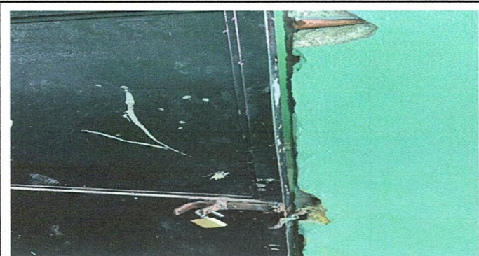
FOTO 4: MANTENIMIENTO A PUERTAS DE SANITARIOS
