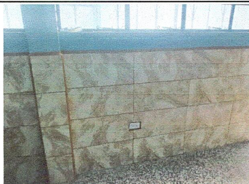
Foto 2: Sustitución de azulejos en paredes de cocina
