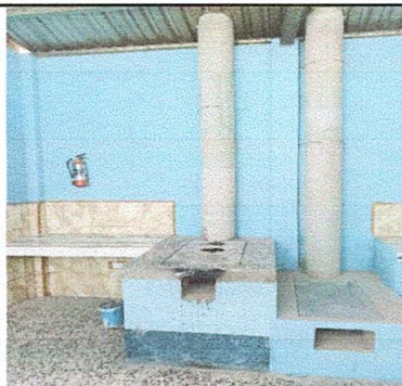
Foto 5: Sustitución de chimenea de concreto
