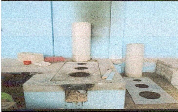
Foto1: Colocación de chimenea de concreto
