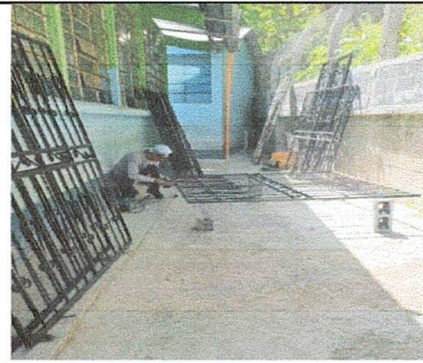
Foto 6: Colocación de los balcones atrás del aula del modulo 1
