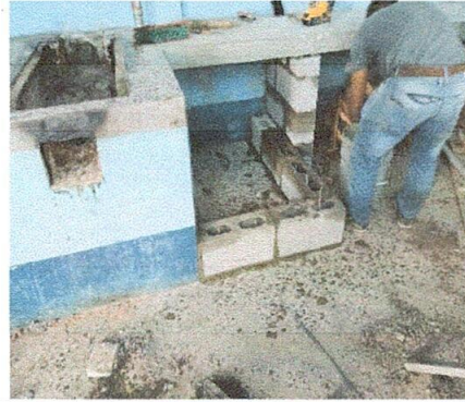
Foto 2: Proceso de mantenimiento de las planchas
