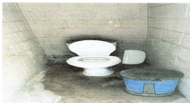
FOTO 3: Sustitución de sanitario y azulejo y piso antideslizante
