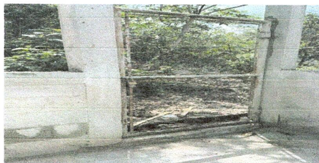
FOTO 2: Reparación de portón de metal
