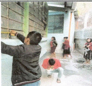
Foto 5: Planificando la sustitución de balcones
