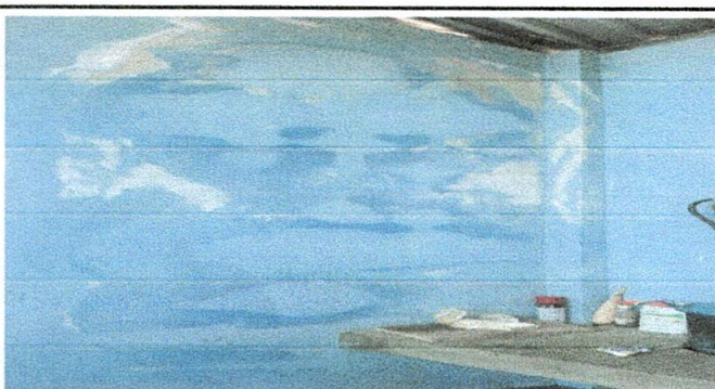
FOTO 5: Impermeabilización de pared y aplicación de pintura en muros
