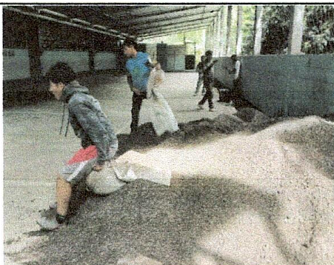
Foto 4: Padres de familias cargando materiales para la sustitución de losa de patio
