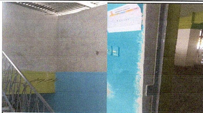
Foto 1: trabajo termiando de cernido y repello
