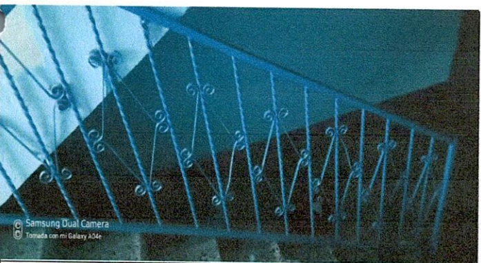
Foto 5: mantenimiento a baranda
