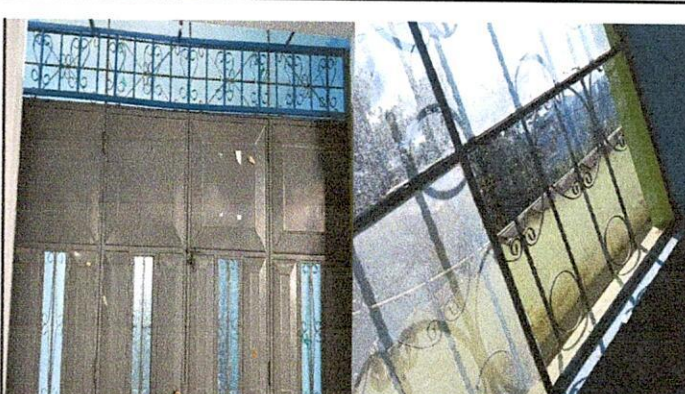
Foto 4: colocación de vidrios en las ventanas y puertas
