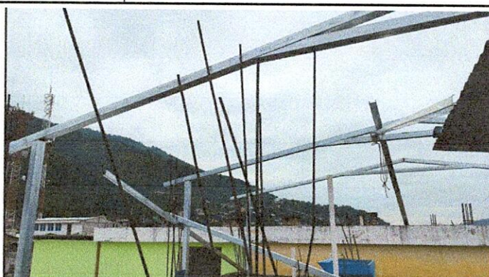
Foto 2: colocacion de estructura de techo
