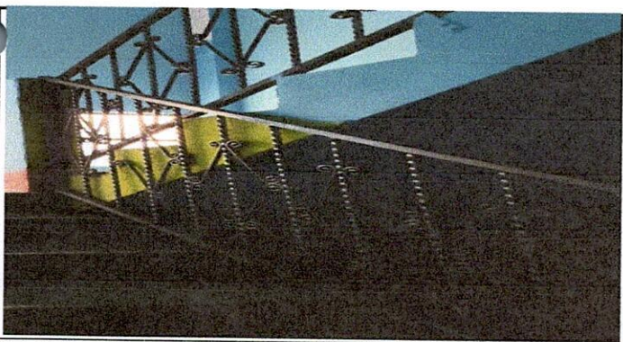
Foto 5: mantenimiento a baranda
