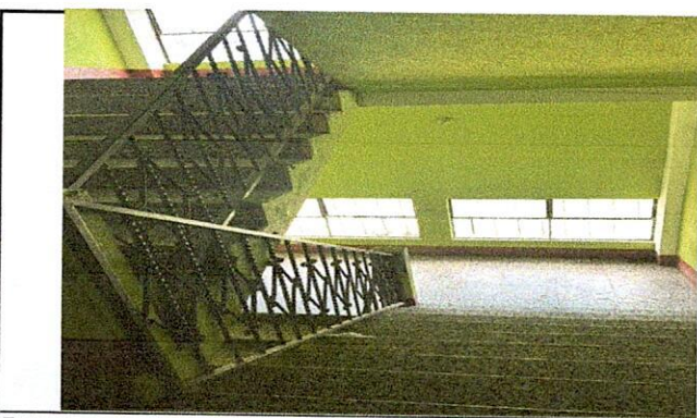
Foto 5: mantenimiento a baranda
