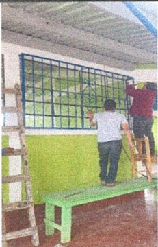
Foto 5: MEJORAMIENTO DE BALCONES EN VENTANAS (FINALIZADO)
