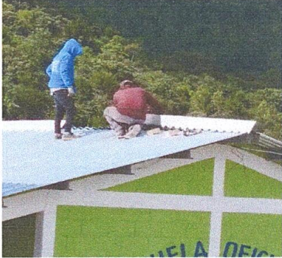
Foto 2: ESTRUCTURA DE TECHO: INSTALACION DE LAMINAS, CAPOTE Y SOPORTE DE METAL ( LIJADO Y PINTADO)
