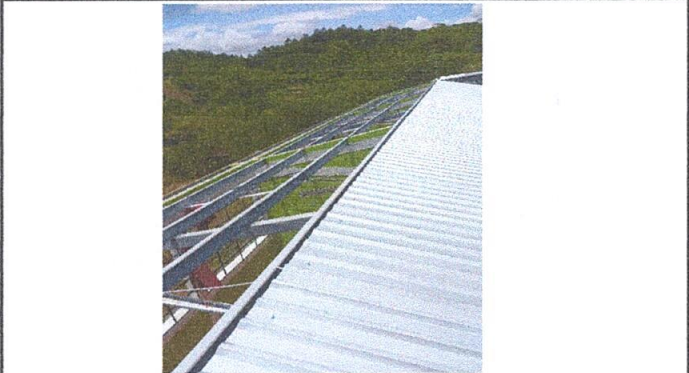
Foto1: INSTALACION DE LAMINAS
