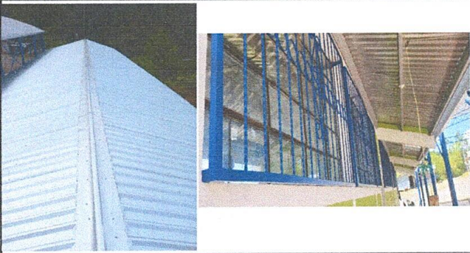
Foto 6: REGLONES DE TRABAJOS FINALIZADO
