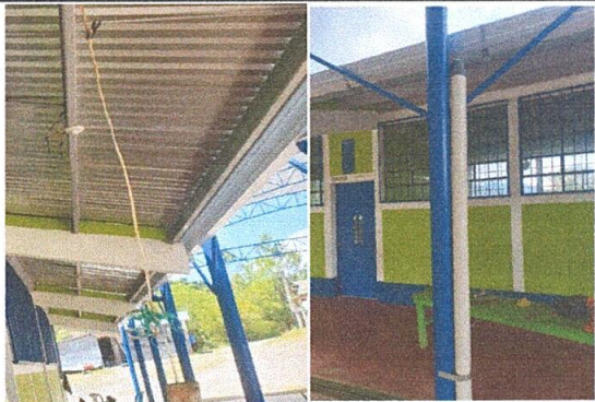
Foto 4: MEJORAMIENTO DE CANALES BAJAS Y PESCANTE DE METAL
