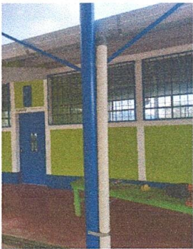
Foto 5: INSTALACIÓN DE CANALES, DE BAJAS Y PESCANTE DE METAL
