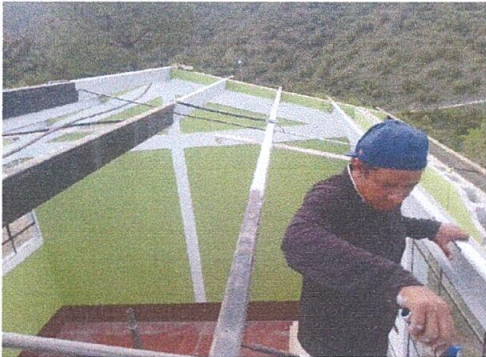
Foto 2: ESTRUCTURA DE TECHO: MANTENIMIENTO DE ESTRUCTURA DE SOPORTE DE METAL ( LIJADO Y PINTADO)
