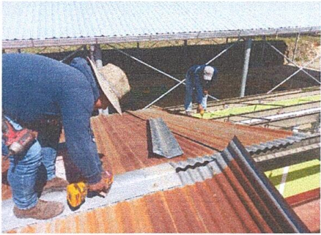
Foto1: INICIO DEL TRABAJO DESMONTAJE DE LAMINAS
