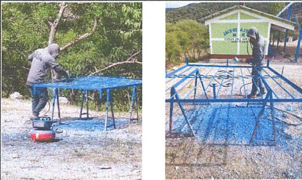
Foto 4: FABRICACIÓN DE BALCONES (PINADO)
