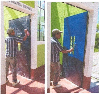
Foto 3: PUERTAS DE METAL: MANTENIMIENTO DE PUERTAS DE METAL(LIJADO Y PINTADO)
