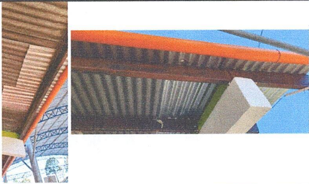
Foto 4: CANALES Y BAJADAS DE AGUA PLUVIAL: SUSTITUIÓN DE CANAL, DE BAJAS Y PESCANTE DE METAL
