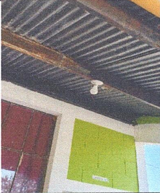
Foto 2: ESTRUCTURA DE TECHO: MANTENIMIENTO DE ESTRUCTURA DE SOPORTE DE METAL ( LIJADO Y PINTADO)
