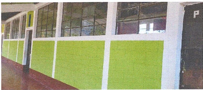
Foto 3: PUERTAS DE METAL: MANTENIMIENTO DE PUERTAS DE METAL(LIJADO Y PINTADO) MEJORAMIENTO DE BALCONES EN ÁRES DE VENTANAS (FABRICACIÓN E INSTALACIÓN)
