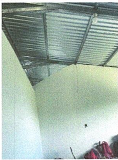
Foto 5: Reparación de repello y cernido de paredes
