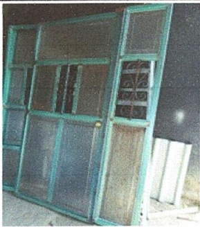
Foto1: Puertas de entradas principales
