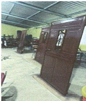
Foto 2: Mantenimiento, lijado de puerta.
