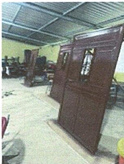
Foto 3: Mantenimiento, lijado de puerta.
