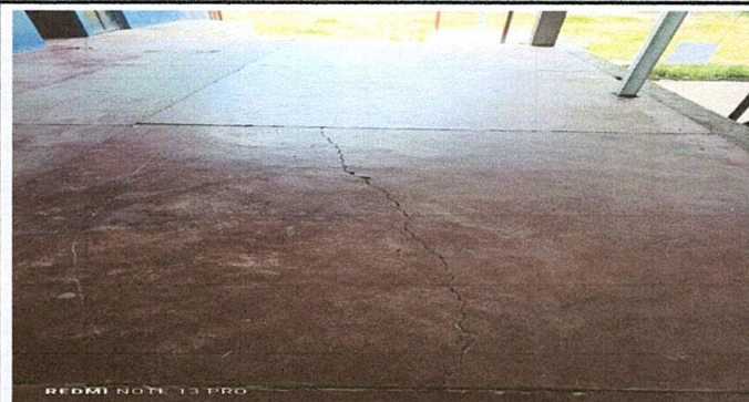
FOTO 2: Sustrucción de piso por piso granito
