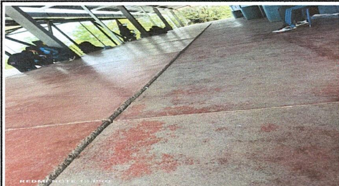
FOTO1: Sustrucción de piso por piso granito
