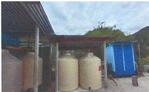
Foto 5: Colocación de tinacos
