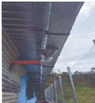
Foto 3: Canales cuadrado de metal colocados
