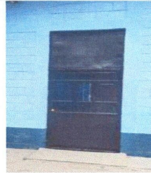
Foto 2: Puertas de metal colocados
