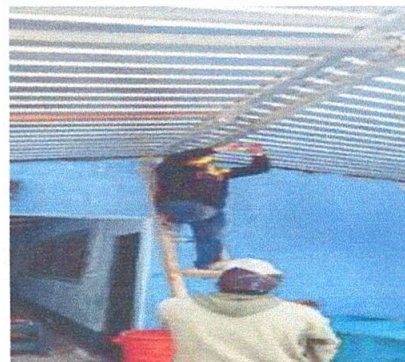
Foto 4: Instalación del sistema eléctrico
