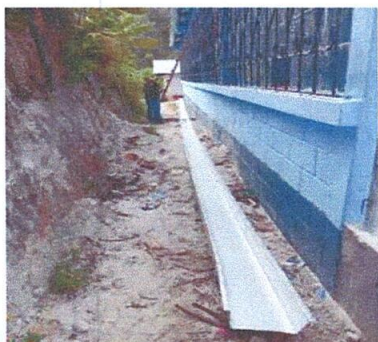
Foto 3: Colocación de canal cuadrado de metal
